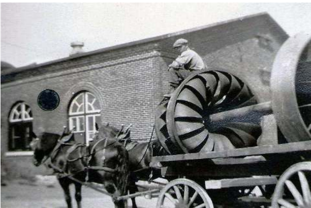
De la gare, les charretiers transportent les lourds matériaux à la centrale. Photo prise en 1921. Collection: Famille Panet
